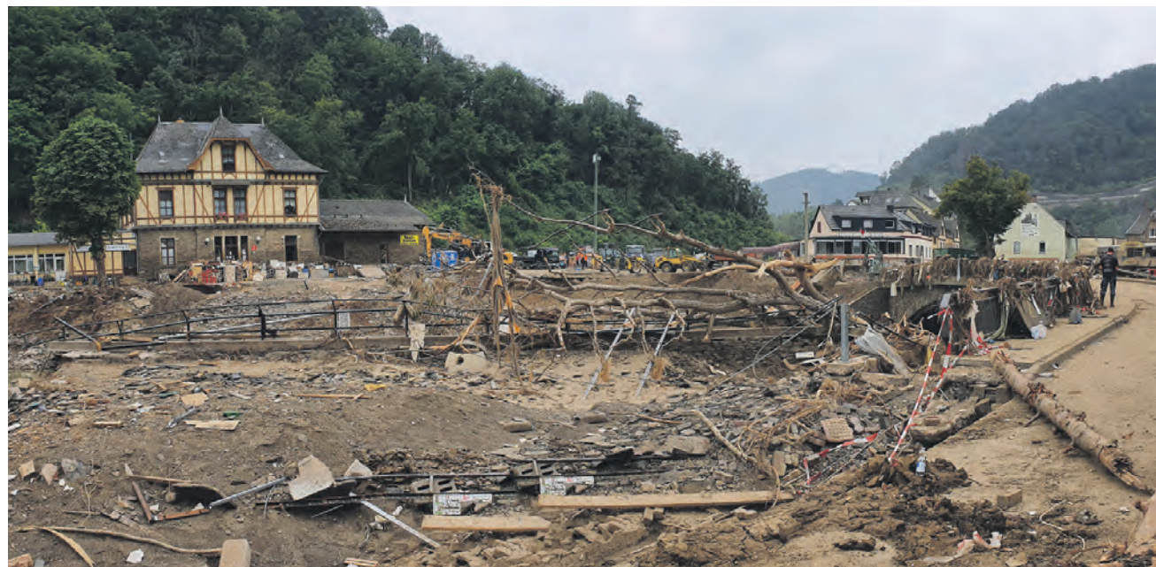
Die Unwetterereignisse und deren Verheerende Folgen in Deutschland sorgten auch in Liechtenstein für Entsetzen. Das Bild zeigt die Ahrbrücke in Altenahr (Rheinland-Pfalz) acht Tage nach der Flut.
